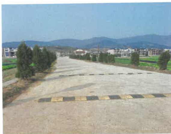
坊上村 1、2、3、4、5、8 组通组公路
