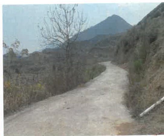
阮家畈村煤蓬至东门段公路硬化
