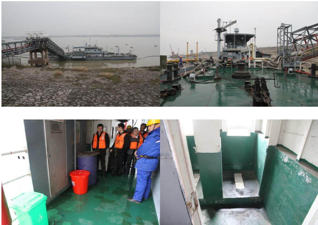
图 3-8 西塞山油库码头及趸船现状
