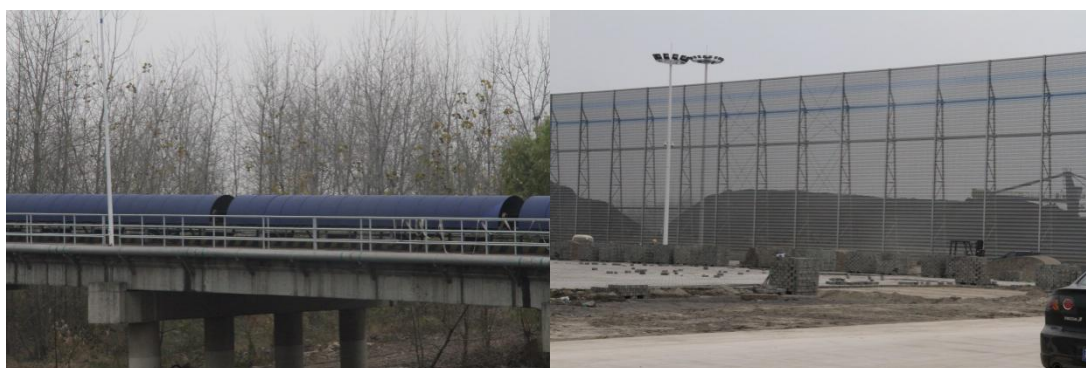
图 3-6 黄石新港散货作业区防尘设施
