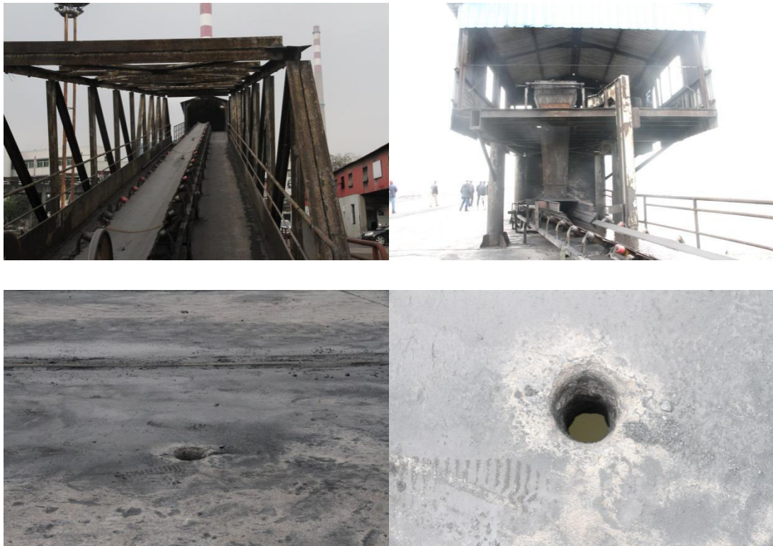
图 3-2 码头的传送带和排水孔
